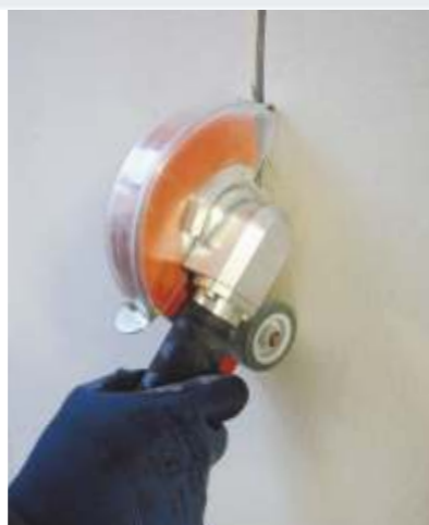
Crearea canalelor pentru cabluri electrice
