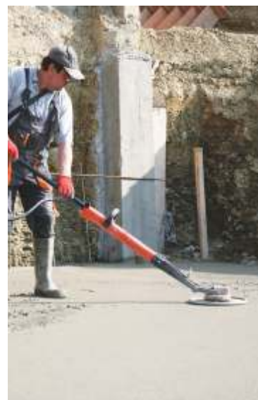
Nivelarea betonului proaspăt
