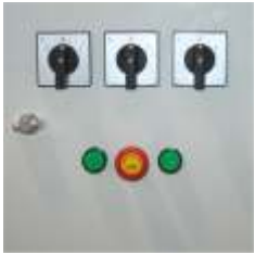
Panou de comandă cu releu de supraveghere a succesiunii fazelor.
