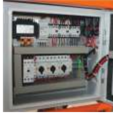
Panou de comandă cu releu de supraveghere a succesiunii fazelor.
